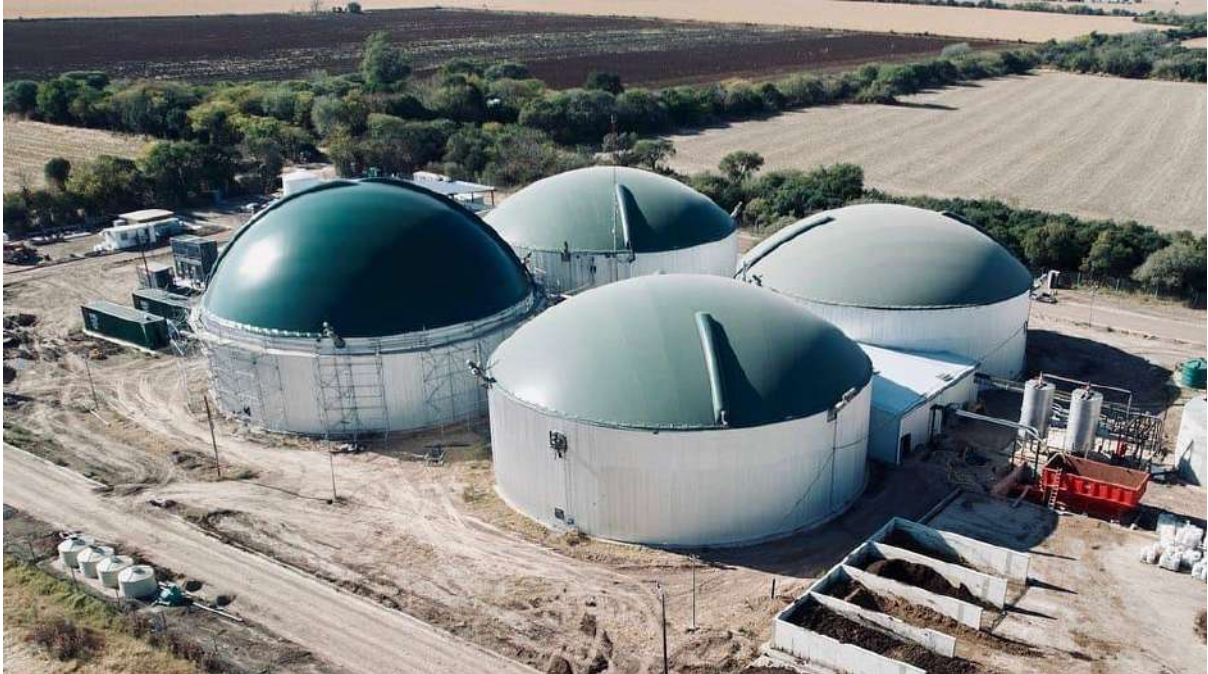
Figura 2.4.4. Los cuatro biodigestores de la planta Helios. Fuente: MejorEnergía [21]
