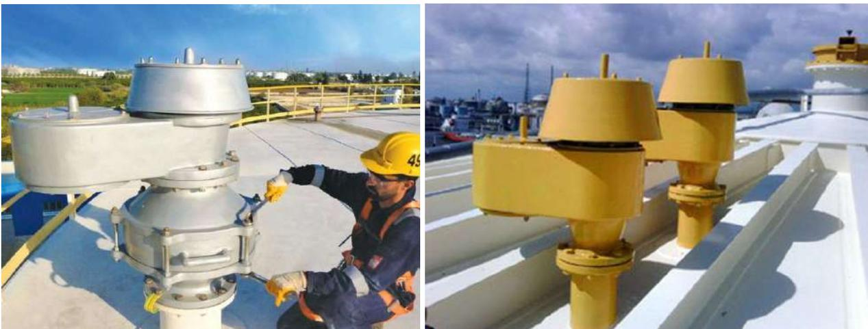
**Figura 26 Válvulas de presión vacío**
