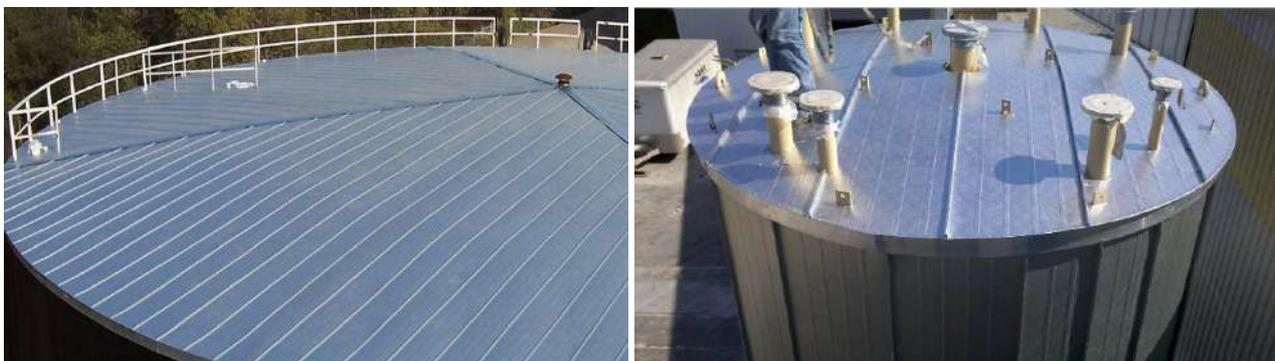
**Figura 7: Techos de tanques aislados**
