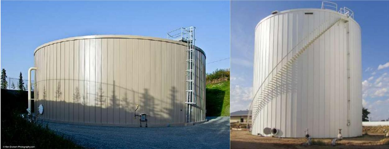
Figura 6: Envoltentes de tanques aisladas
