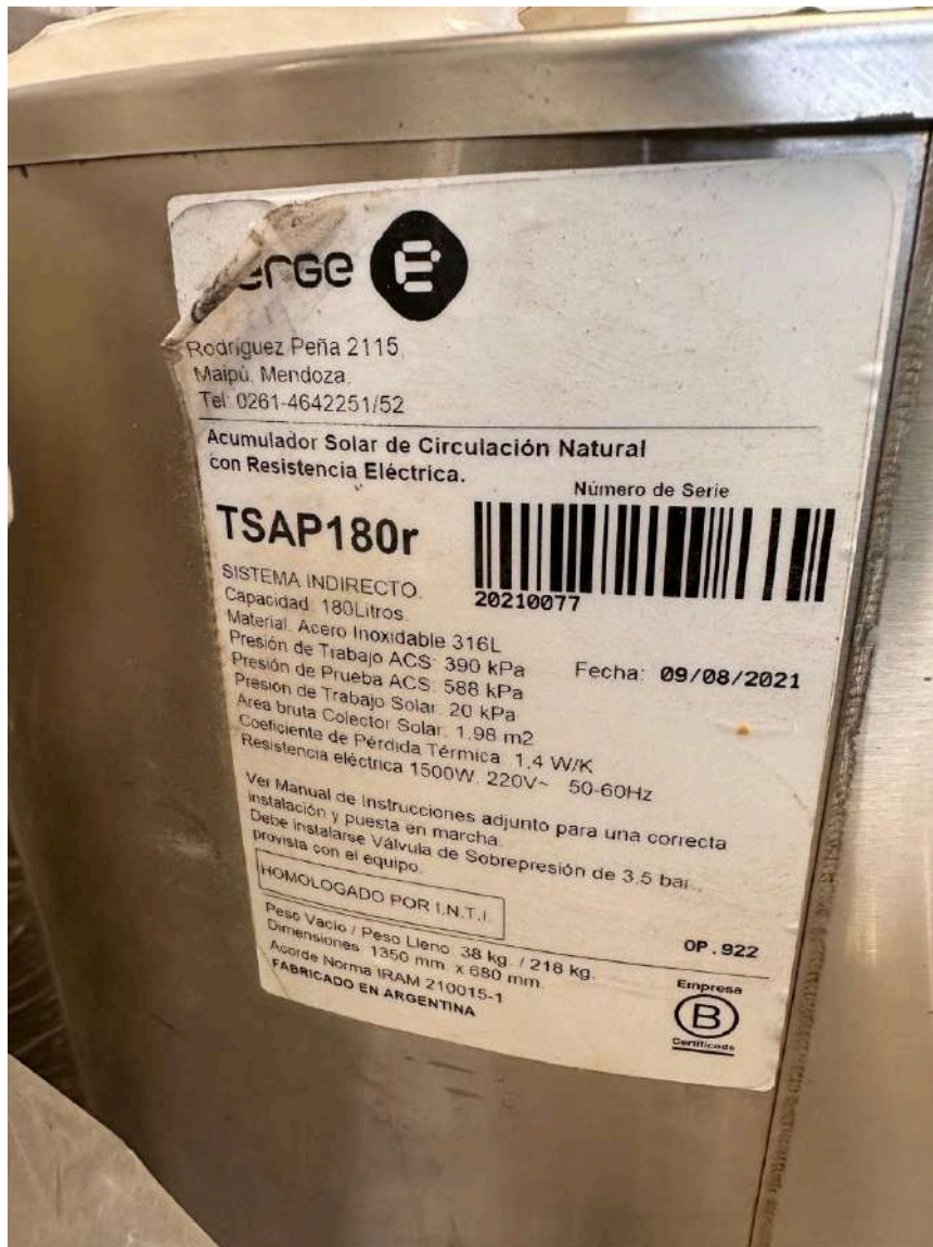
Figura 52. Ficha técnica del acumulador del fabricante Energe disponible en la Facultad de Ingeniería.
