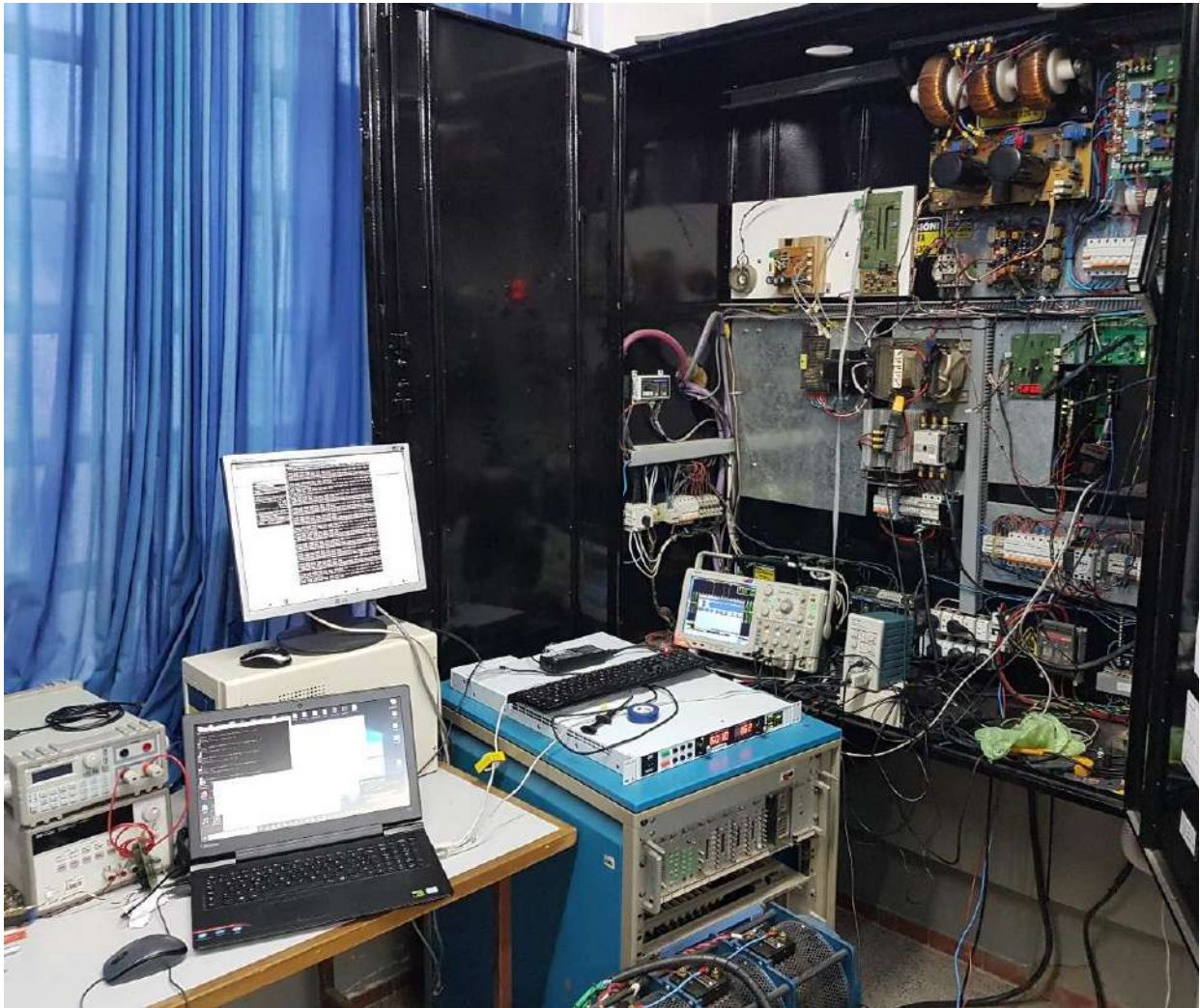
Sistema completo inyectando a la red 10 KW junto a instrumentos de medición y CLI para comandar sistema de control.
