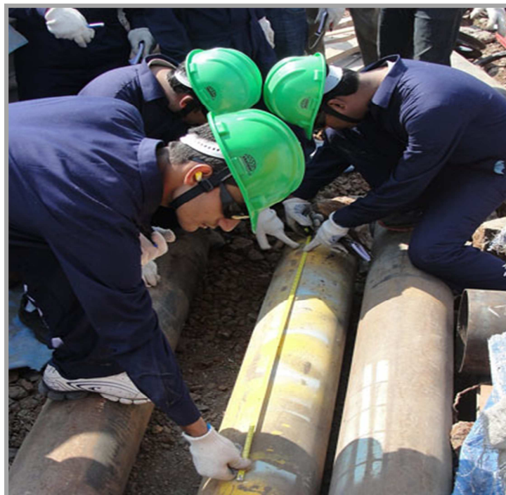
Figura I.1 - Medición de la longitud de los tubos con cinta de acero.
