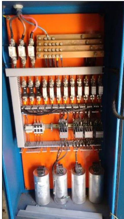
Fig. 5.2. Banco de Capacitores Económicas – Tablero Primario
