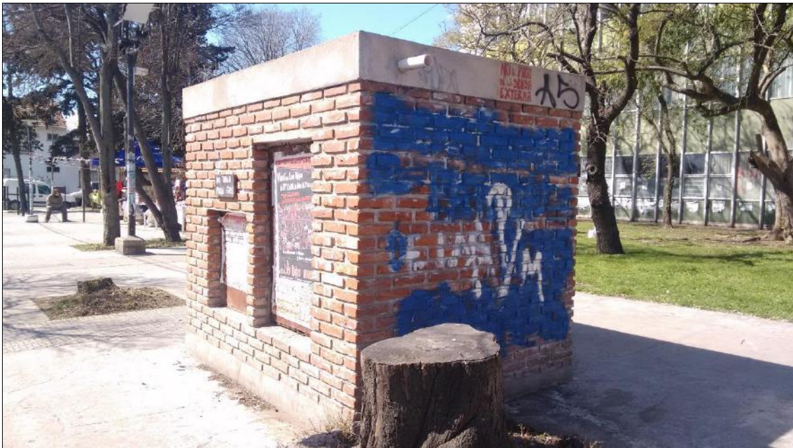
Fig. 1.3. Tablero Primerio Subestación S1
