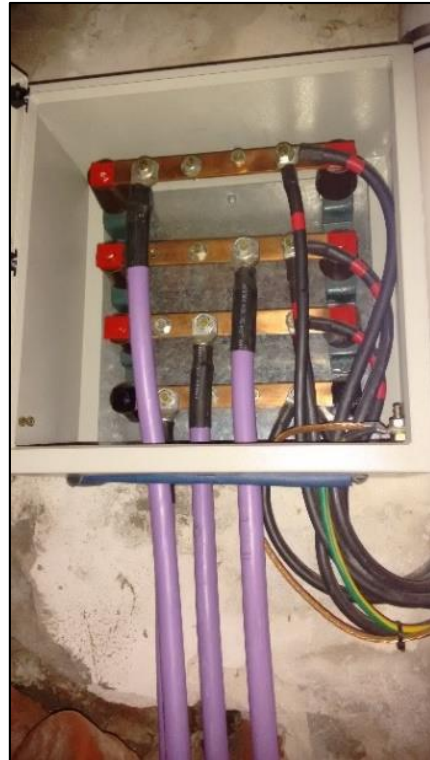
Fig. 5.3. Alimentación a Tablero Económicas y caja de pase estanca - Subsuelo
