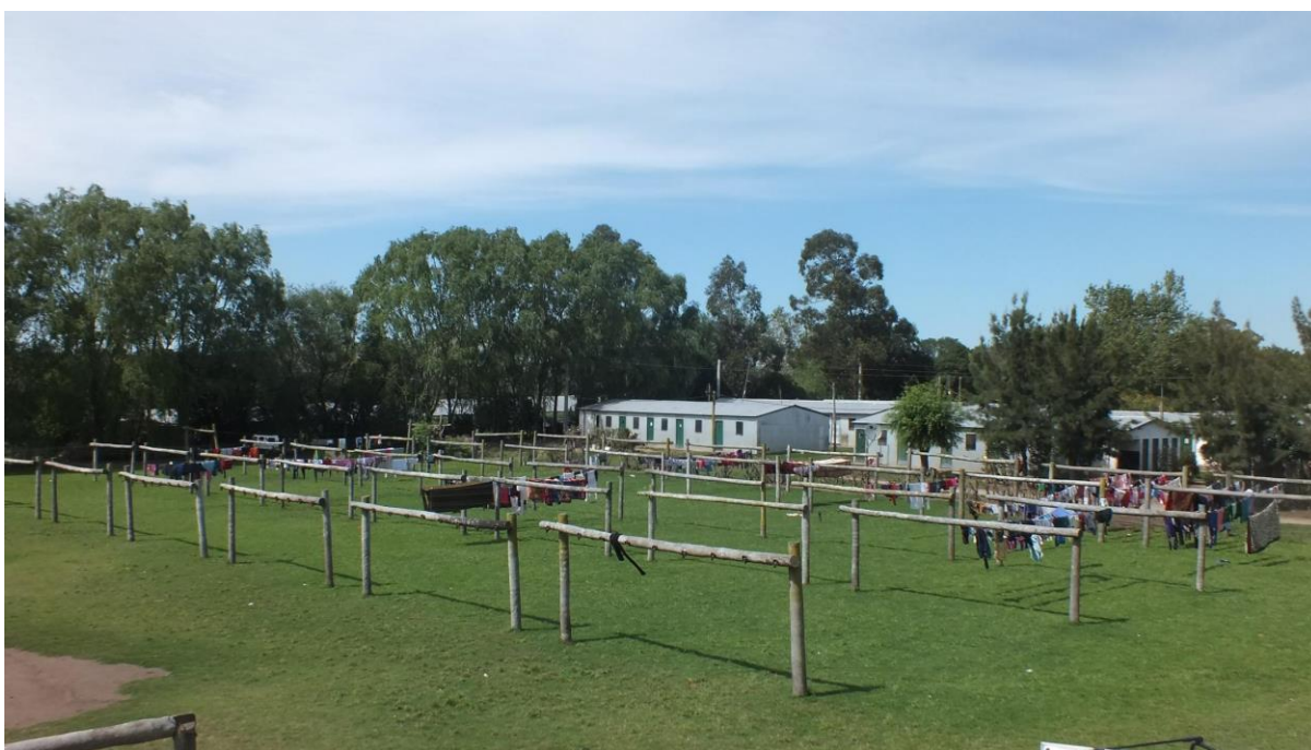
Figura 5: Instalaciones del Complejo Habitacional. Fuente: CIFSA
