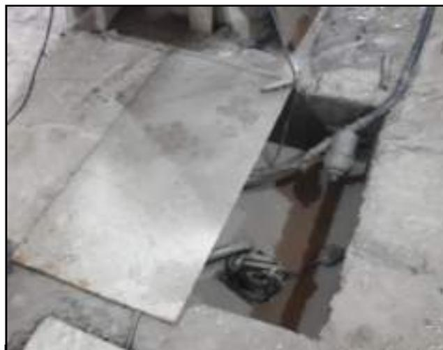
Figura 57- Pozo de recolección de barros, zona cortadora eléctrica. Fuente propia.
