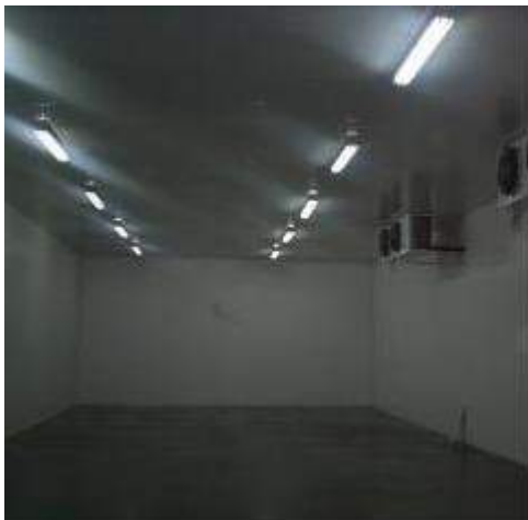
Ilustración 5: Cámara de Refrigeración
