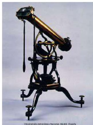
Figura 24: Pirheliómetro de P. Dollond 1785
