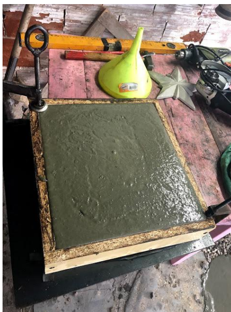
Figura 17. Encofrado lleno.
