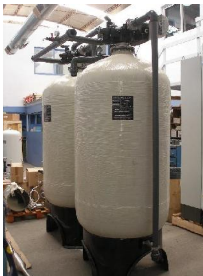
Figura 64: Equipamiento de intercambio iónico tipo Twin.
