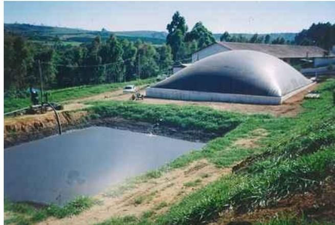
Figura 4: Biodigestor tipo Laguna Cubierta.
