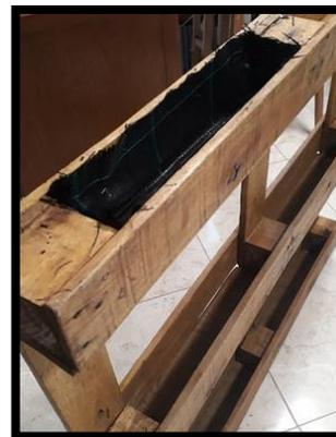
Ilustración 11. Agregado de geotextil.
