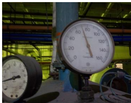
Figura 16. Termómetro caldera 1 Fuente: Elaboración propia
