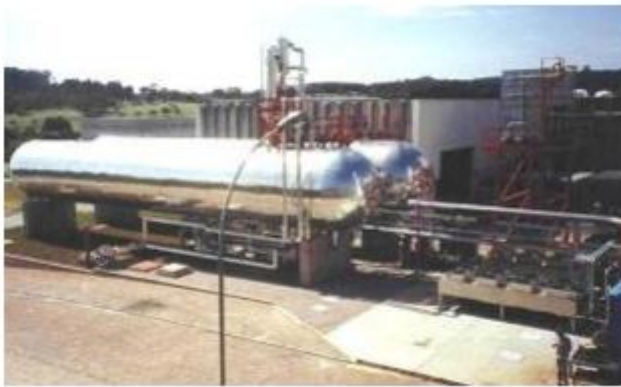
Figura 8.5: tanque de almacenamiento de CO 2
