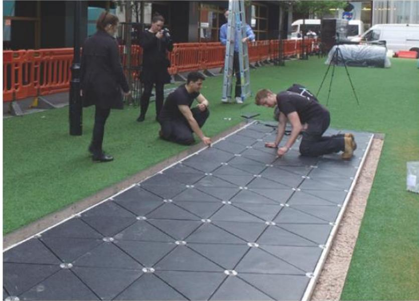
*Ilustración 97: Instalación de baldosas Pavegen*
