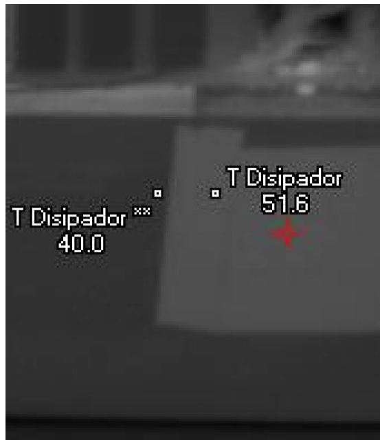
FIGURA 6.11: Termografía de parte del costado del disipador con el equipo operando a la máxima potencia.
