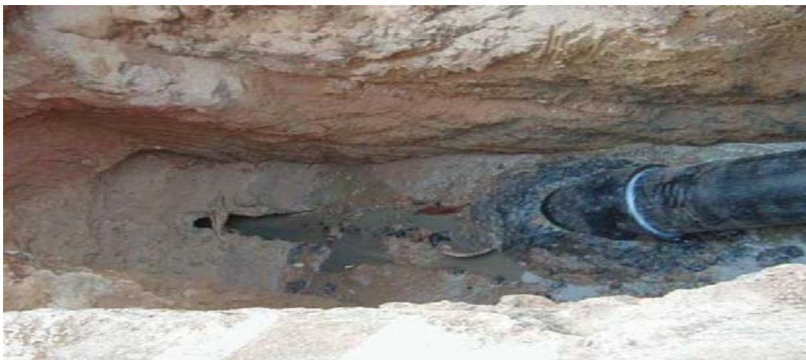
**Figura 19:** Introducción del caño plástico dentro de la vieja línea.
