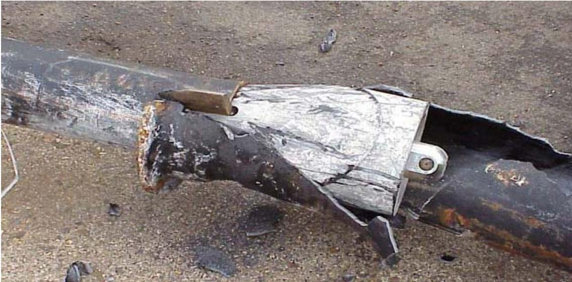
**Figura 15:** Funcionamiento del proceso de “Crack Bursting”.
