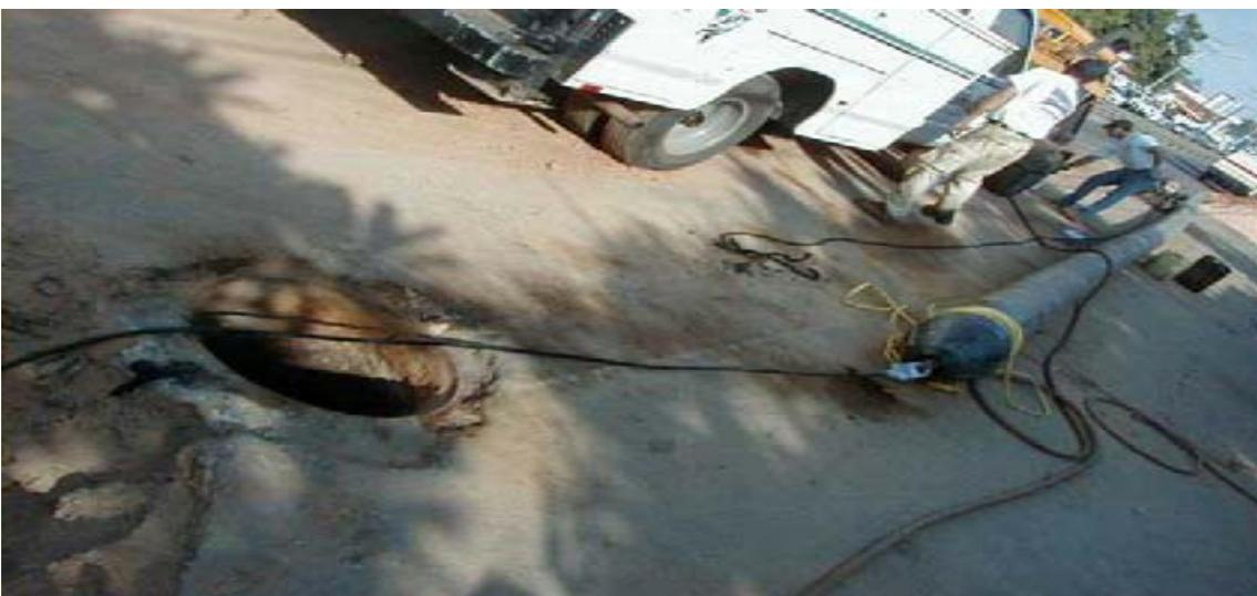
**Figura 17:** Sujeción del caño.
