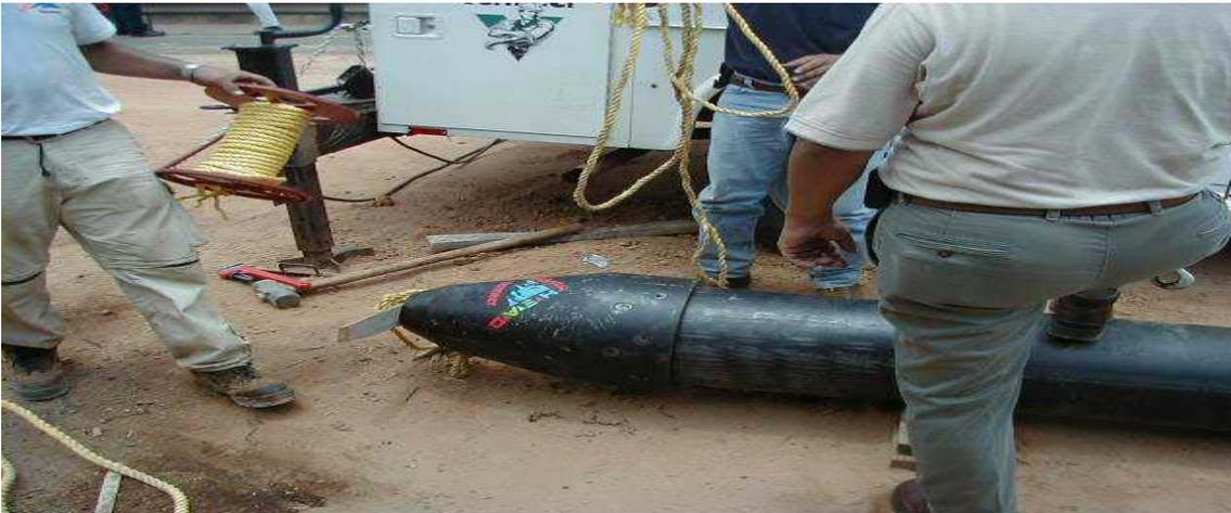
**Figura 16:** Colocación del cabezal de tirado
