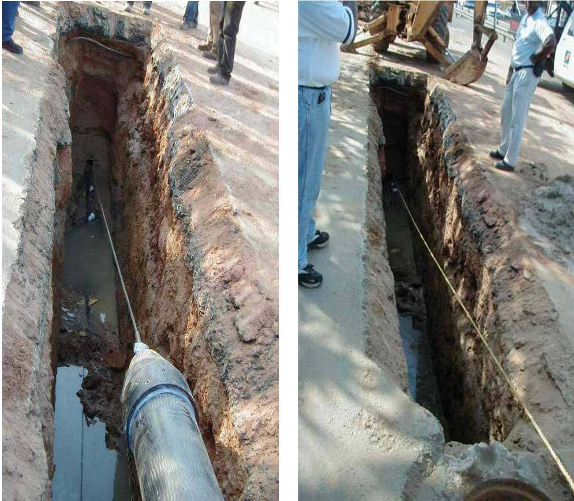
**Figura 17 y 18:** Procedimiento de "Crack Bursting".
