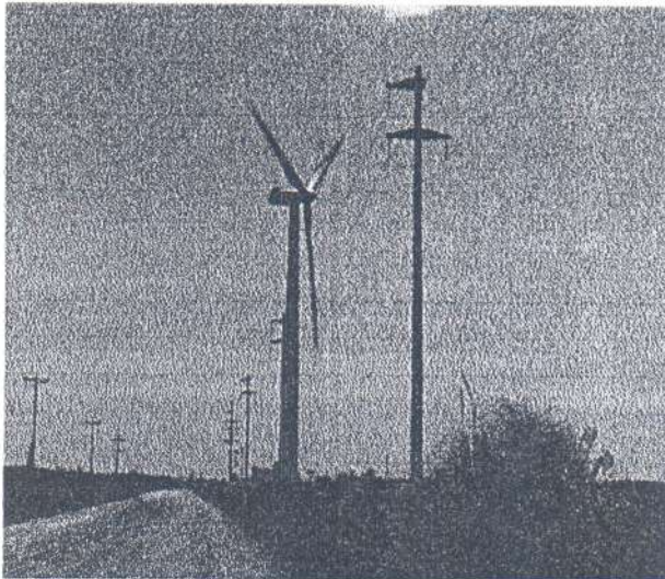
Vista de la central.
