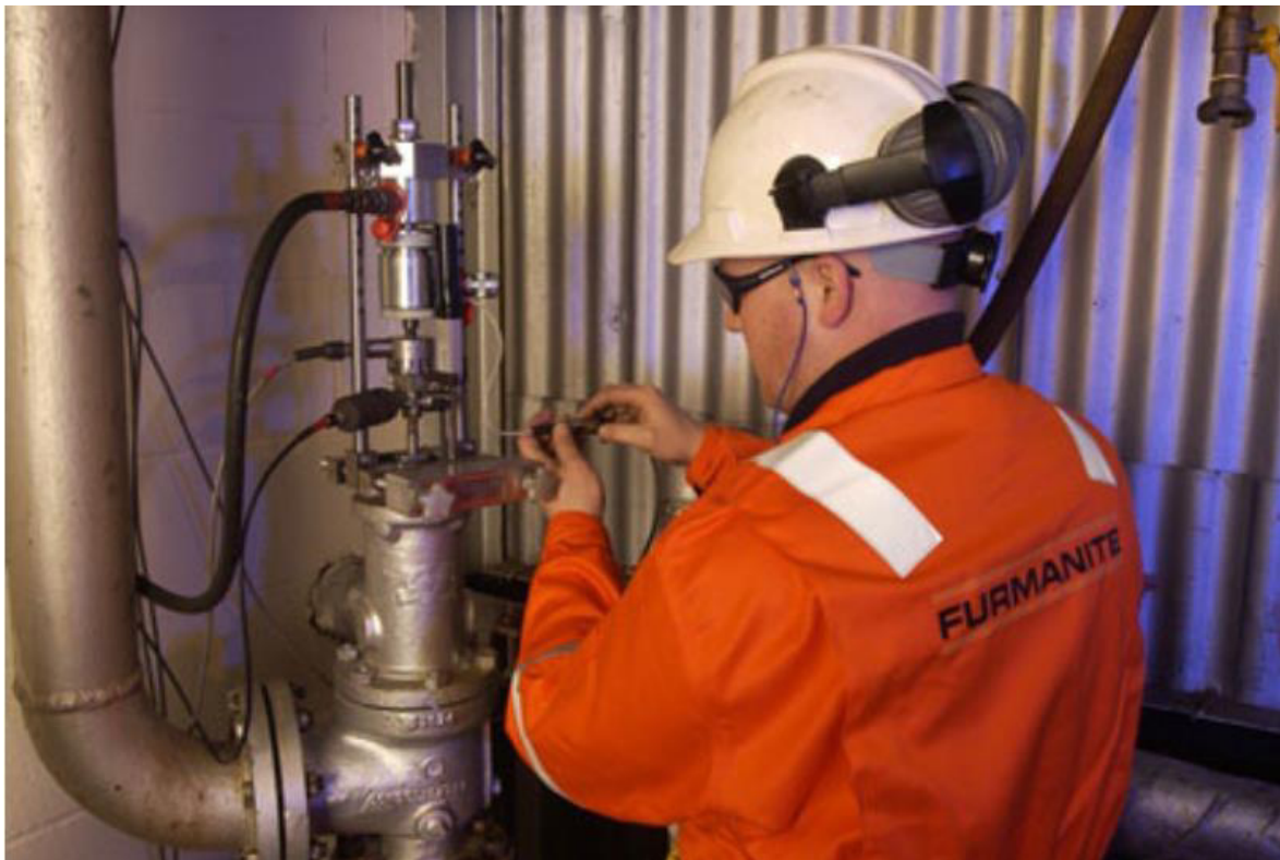
Figura 5-4 Realización de prueba en servicio Trevitest.
