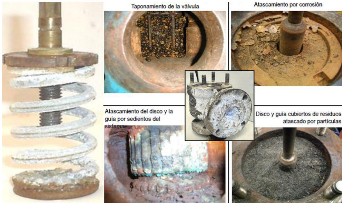
Figura 5-3 - Defectos encontrados en inspecciones .[4]
