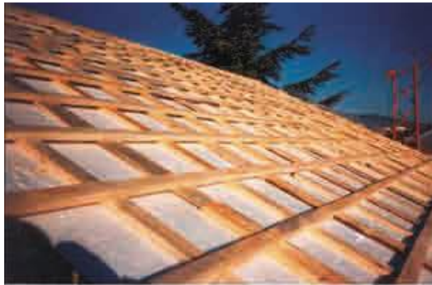
Figura 2.13. Cubierta de poliestireno expandido en techos.
