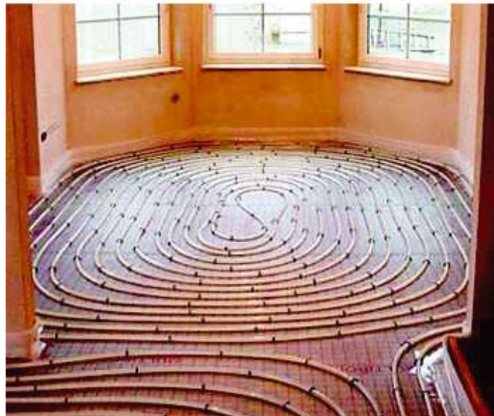
Figura 2.6. Esquema de instalación de piso radiante
