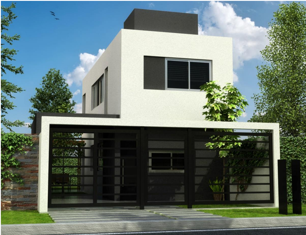
Figura: 0.3. Vista frontal de la vivienda
