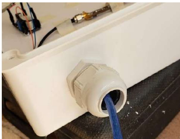
Figura A.51: Foto de la salida del cable al exterior de la caja
