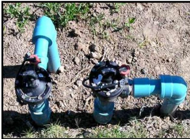
Figura 11 - Válvulas instaladas en tuberías <sup>(1)</sup>.
