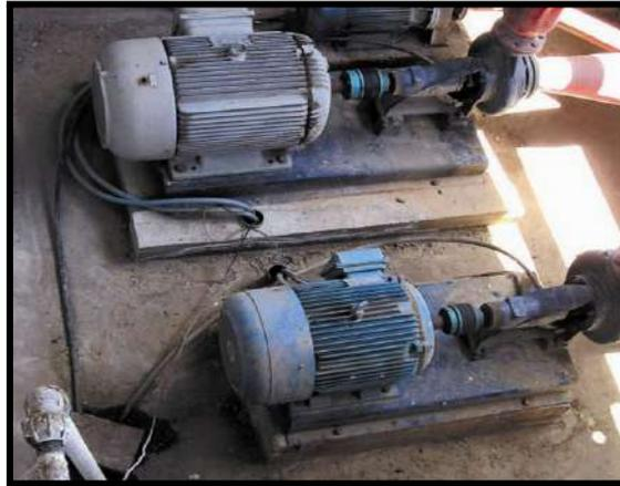
Figura 12 - Bombas centrífugas instaladas en paralelo <sup>(2)</sup>.
