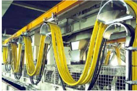
Figura 2.17: Cableado colgante del puente grúa
