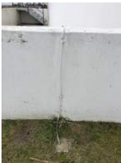
Ilustración 22: Conexión puesta a tierra de los tanques. Fuente: Propia
