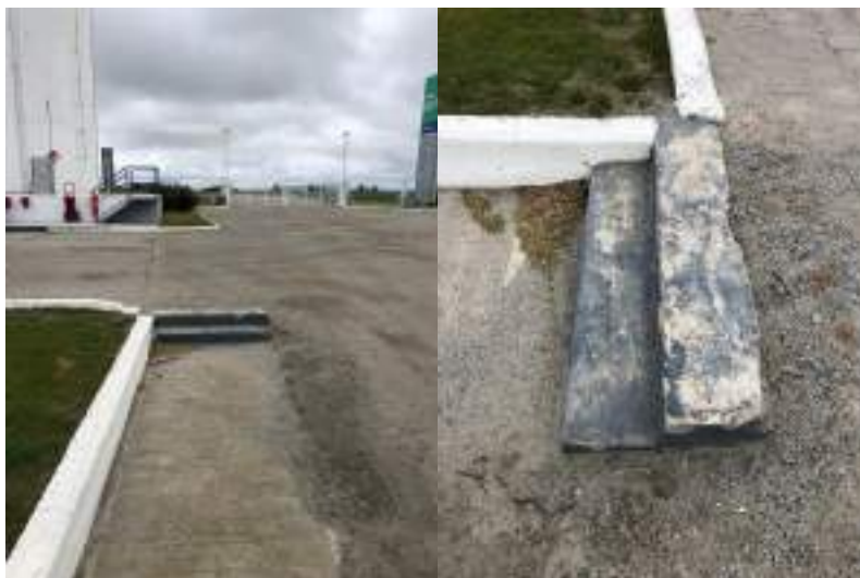
Ilustración 33: Escalones zona bascula de camiones. Fuente: Propia
