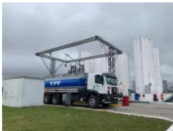
Figura II: Zona de carga y descarga de combustibles líquidos. Fuente: Propia
