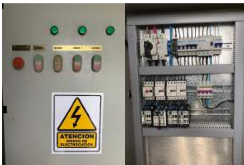
Ilustración 27: Tablero de comando planta de fertilizantes a granel. Fuente: Propia
