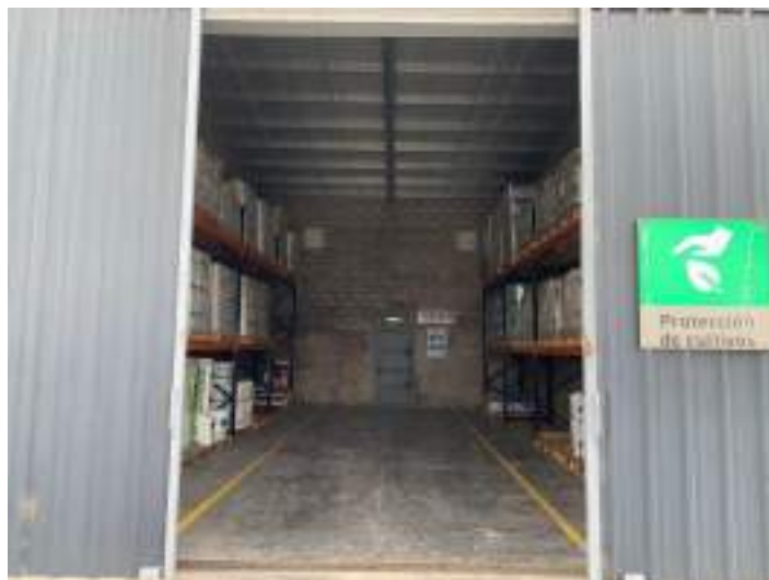
Ilustración 14: Puerta de emergencia y ventilación en depósitos. Fuente: Propia
