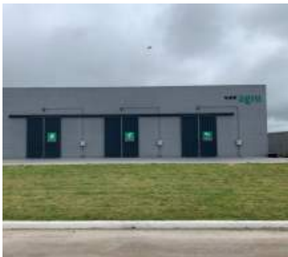
Ilustración 10: Exterior depósito de envasados. Fuente: Propia
