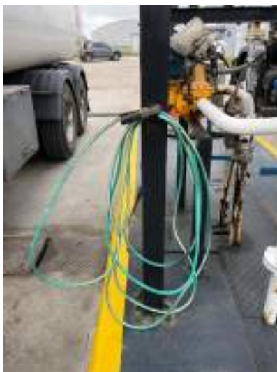
Ilustración 22: Conexión puesta a tierra de los tanques. Fuente: Propia
