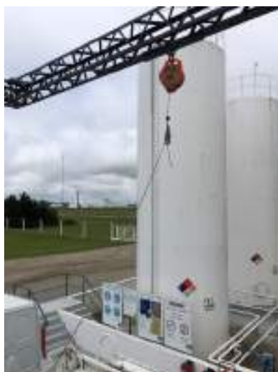
Ilustración 20: Línea de vida del módulo metálico. Fuente: Propia
