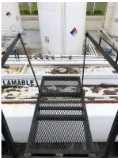
Ilustración 18: Platea metálica para carga top de camiones. Fuente: Propia
