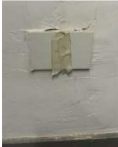
Figura 3. Tomacorrientes incorrectamente anulados por inconveniente eléctrico.
