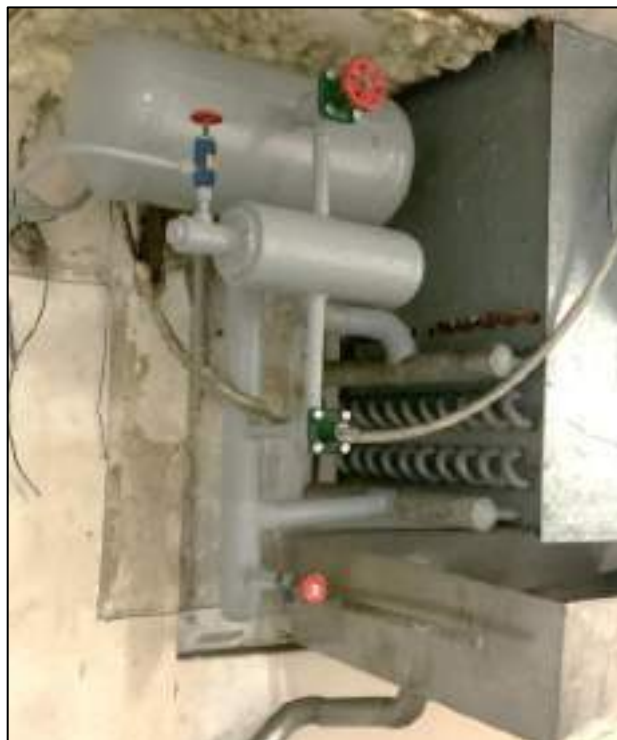
Figura 3.51 - Separador de líquido de evaporador de S-CF1.
