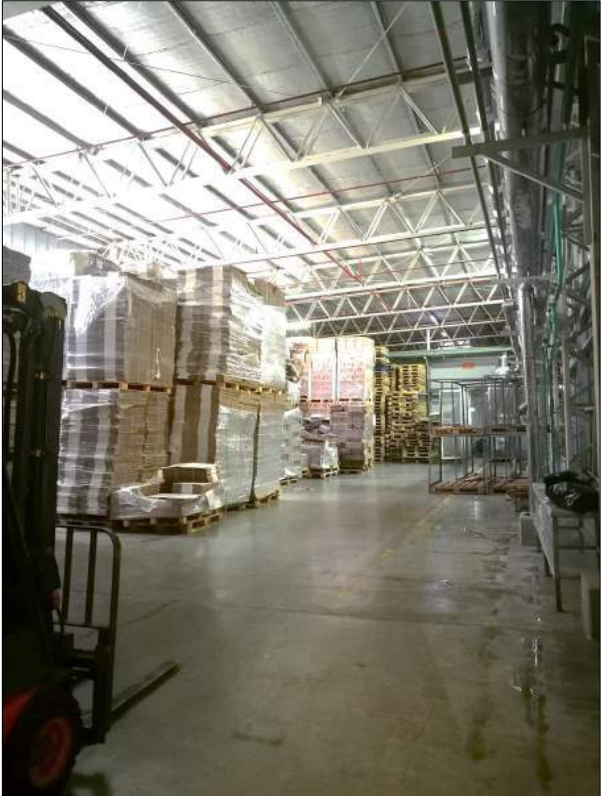
Figura 3.11 - Planta alta, pasillo exterior a cámaras
