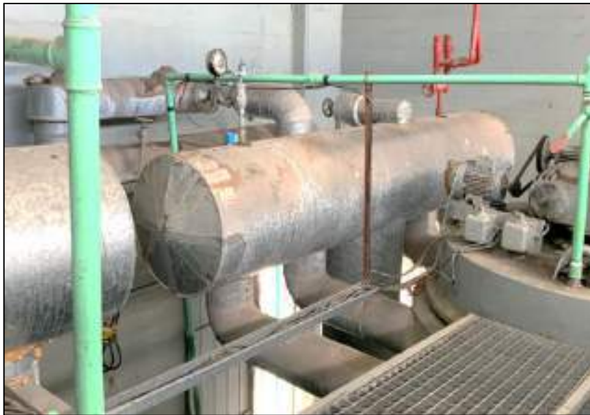
Figura 3.50 - Separador de líquido que alimenta S-MH1.
