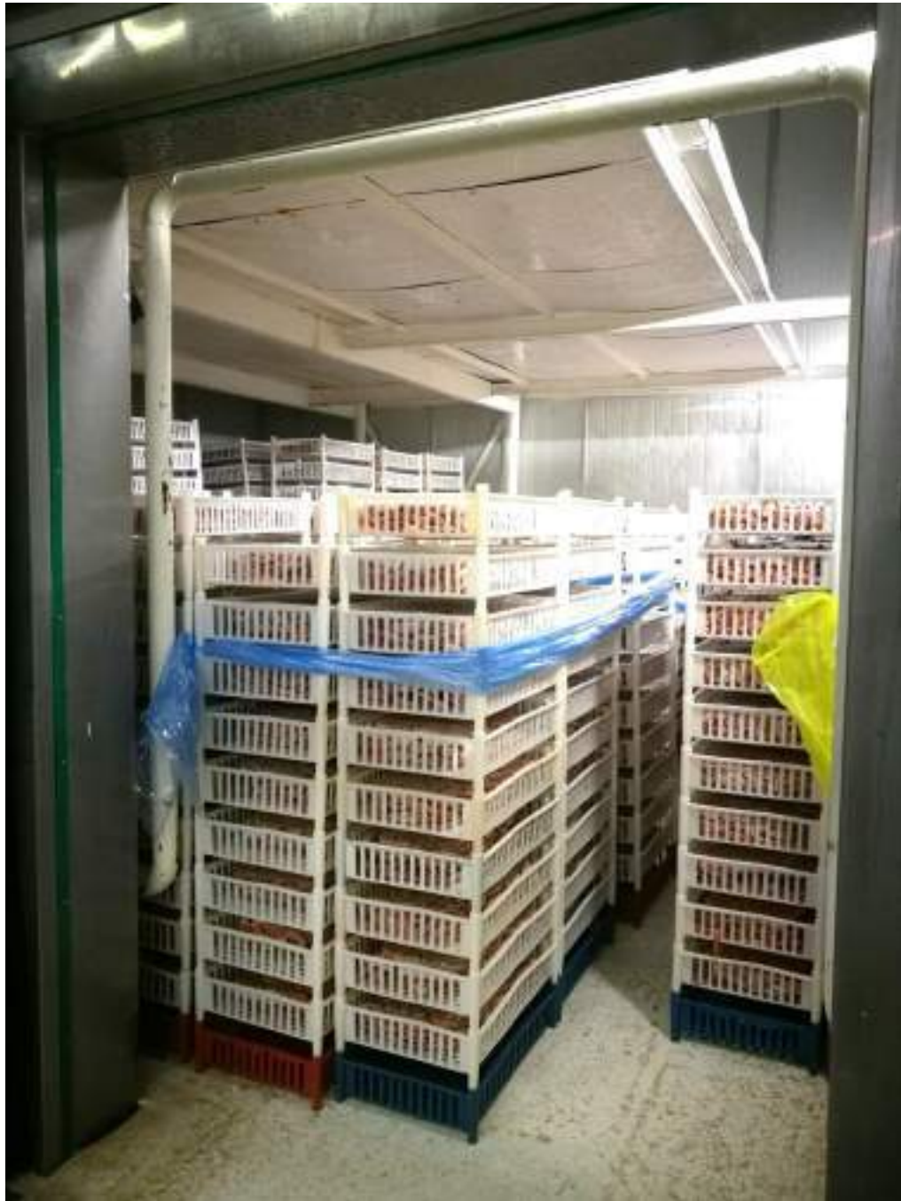
Figura 3.26 - Túnel 3 (S-T03) en servicio, ídem túnel 4 (S-T04)
