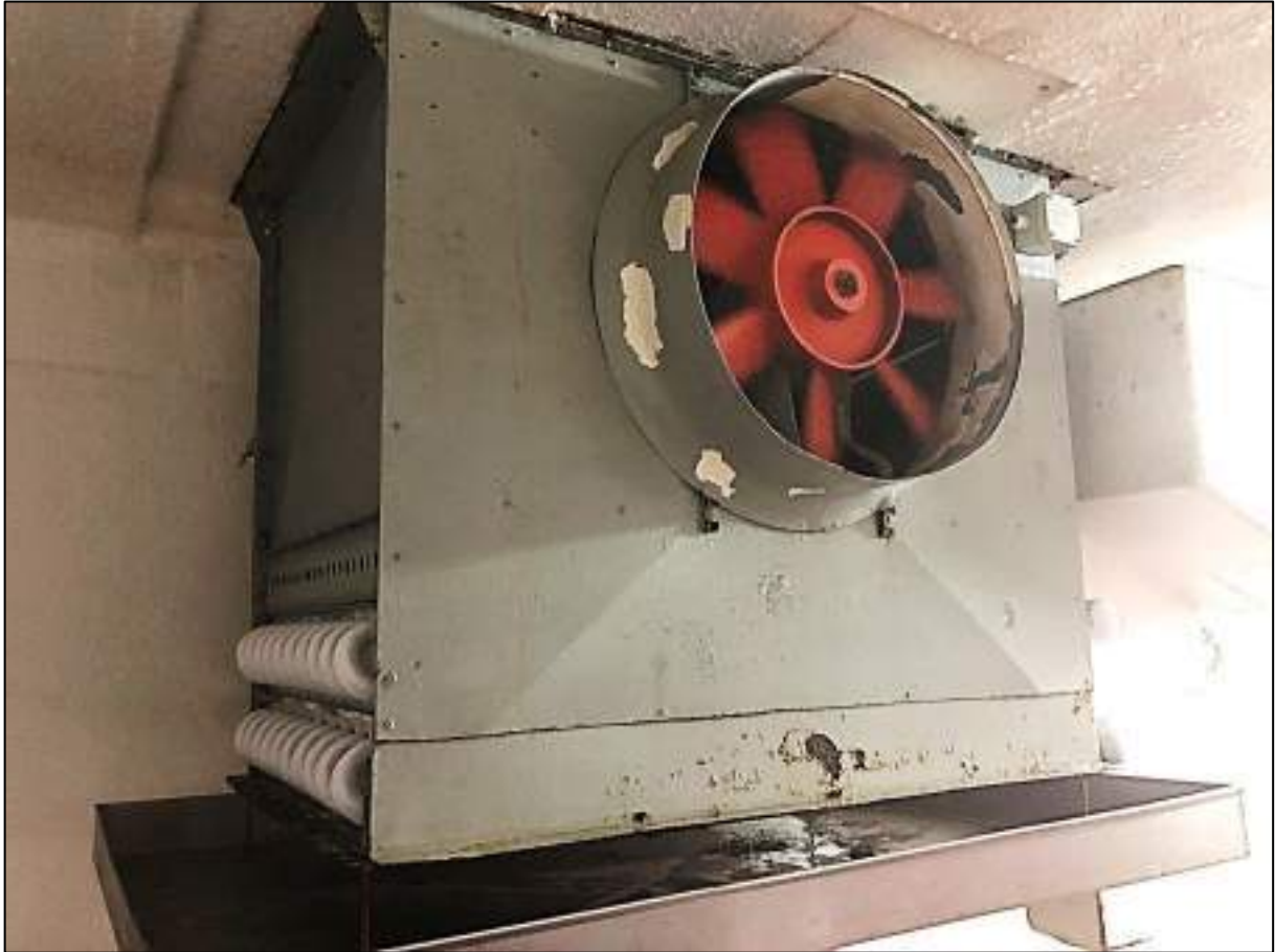
Figura 3.17 - Foto real evaporador cámara de mantenimiento de producto fresco 2, (S-CF2).
