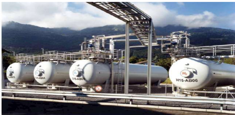
Figura 4.4.3.3: Tanque de baja presión (Fuente LINDE [4.5])
