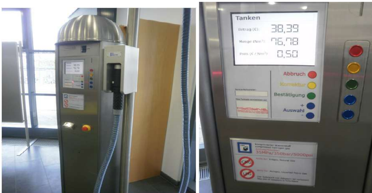
Figura 4.4.5.3: Surtidor experimental de hidrógeno – Presión 350 bar
