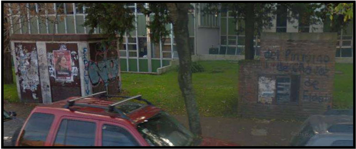
Fig. 7.3. Subestación y acometida sobre la calle Rodríguez Peña.
