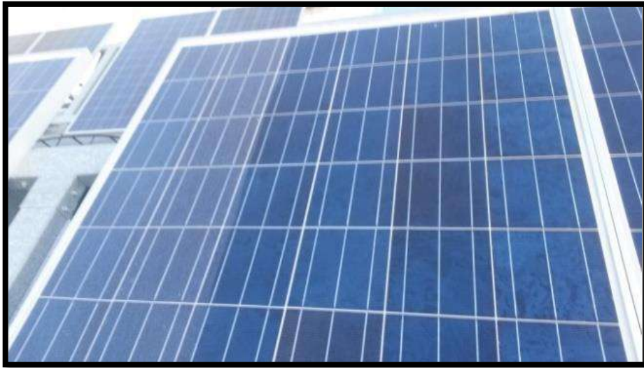
Fig. 11.33. Paneles parcialmente cubiertos por polvo. Fuente: Camila N. De Souza.
