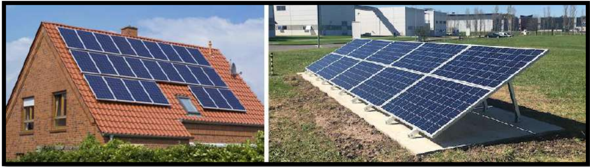
Fig. 3.12. Paneles solares fijados.
