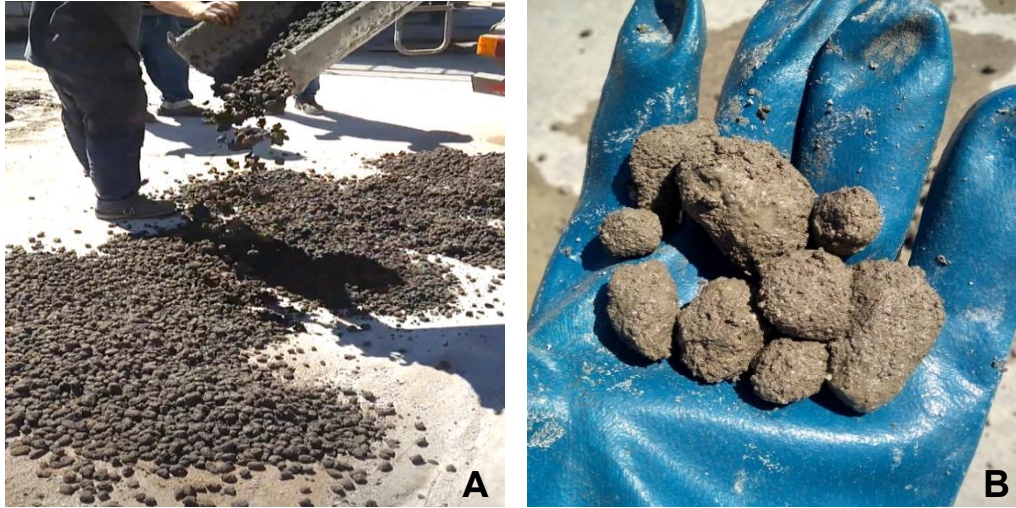
Figura 14. Prueba en camión mezclador. A) Descarga de AR desde camión moto-hormigonero. B) AR obtenidos de prueba en mixer .
