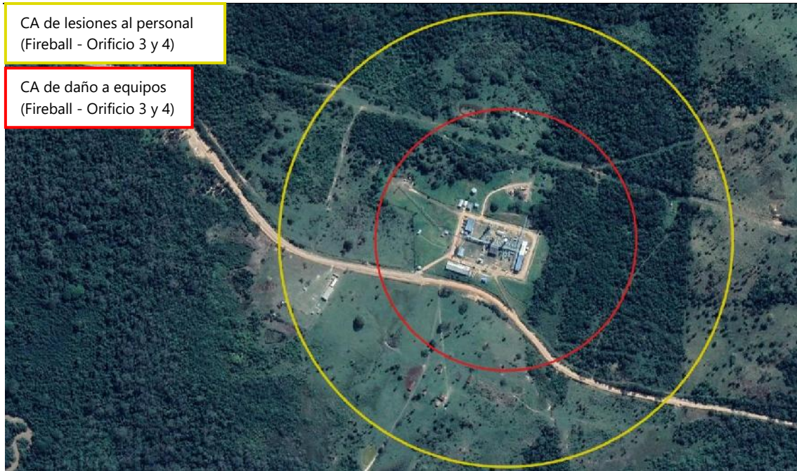
Imagen 4.7. Área de consecuencia por fireball de lesiones al personal y equipos para orificios 3 y 4.
