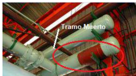
Figura 7.15. Ejemplo de tramo muerto en una planta.
