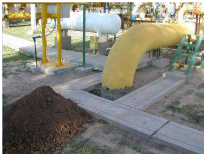
Figura 7.16. Interfaz suelo-aire en cañería no revestida completamente.
