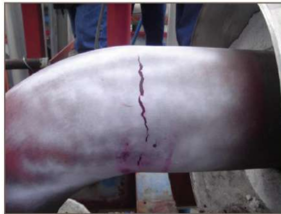
Figura 7.9. Visualización de una fisura gracias a la aplicación de líquidos penetrantes.
