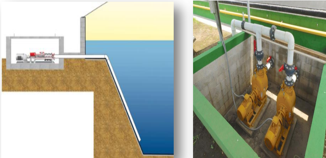
Figura 7.5 - Bomba de extracción de lodos. Fuente: Moncayo, 2017 (Izquierda) y AQUALIMPIA ENGINEERING.
