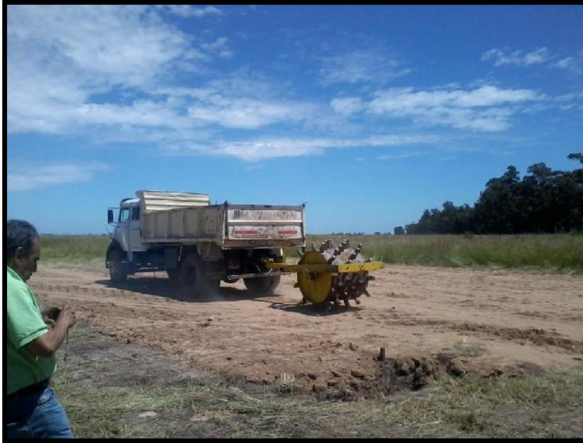
Ilustración 16. Preparación de suelo
