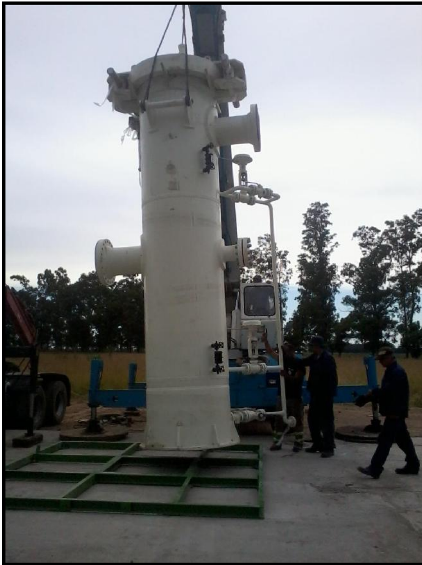
Ilustración 30. Posicionando el separador.
