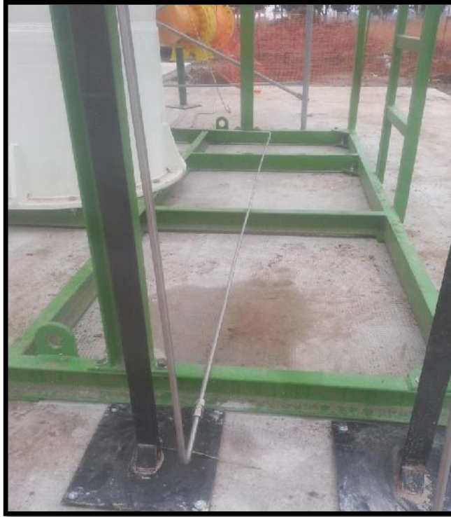
Ilustración 14. Soportería de filtro ciclónico
