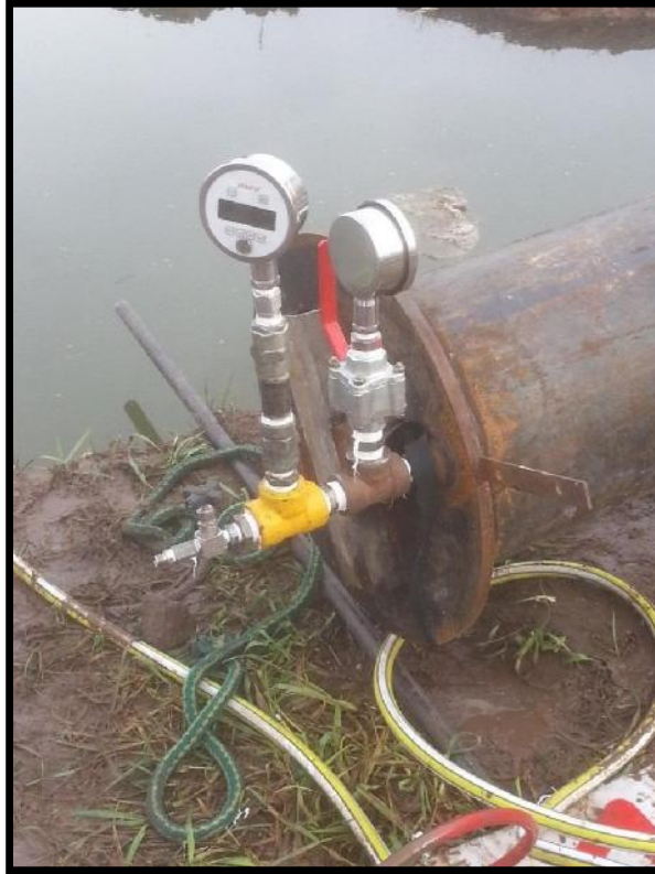
Ilustración 26.Registradores en prueba hidráulica.
