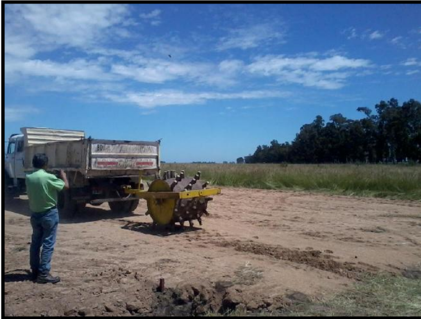
Ilustración 28. Acondicionamiento de superficie
