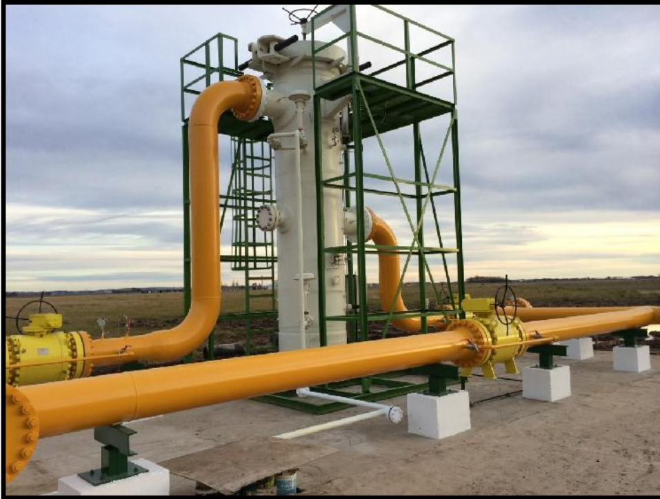
Ilustración 8. Válvulas esféricas 12'' accionadas a volante.
