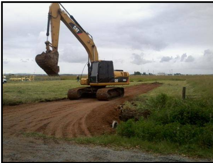
Ilustración 2. Construcción de camino de ingreso
