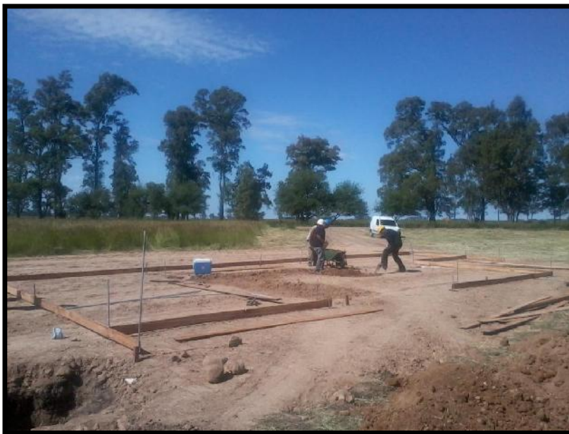
Ilustración 27. Demarcado de superficie
