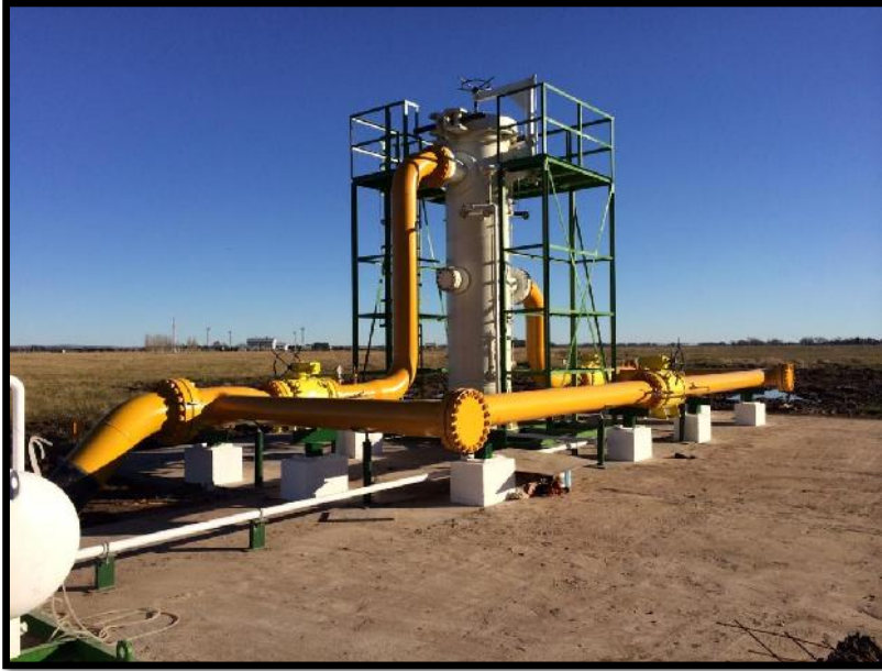
Ilustración 10. Vista en perspectiva de Bypass.
