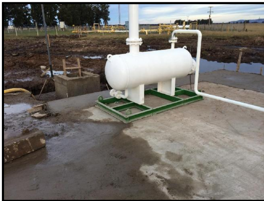
Ilustración 9. Tanque de choque
