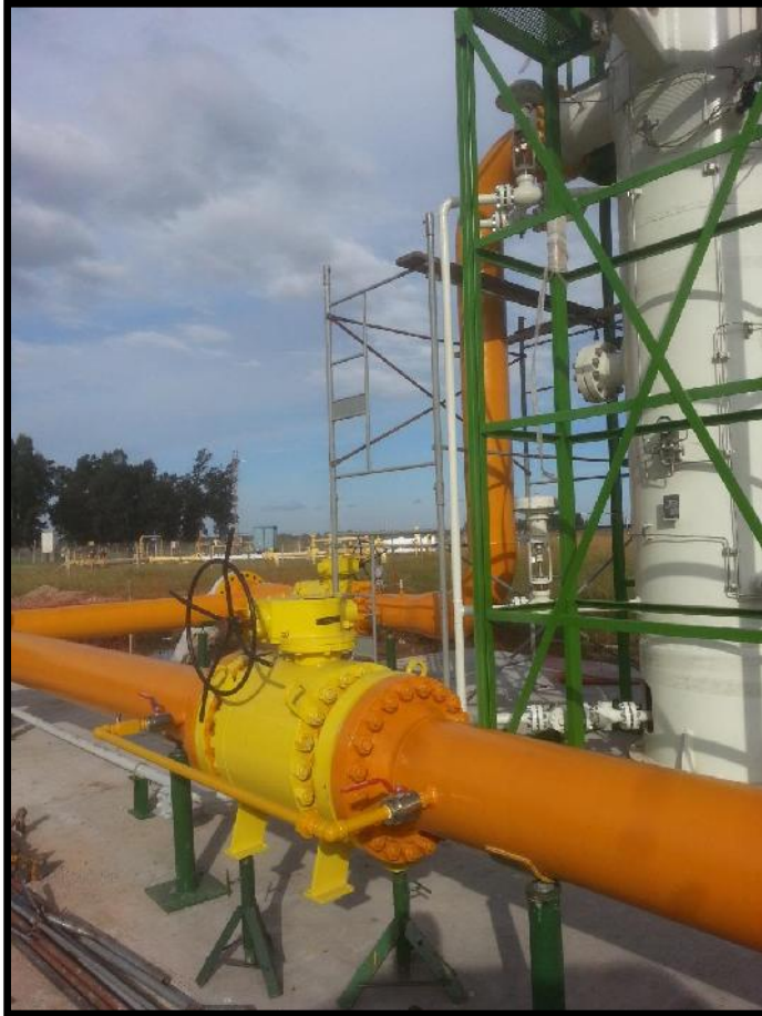
Ilustración 25. Estación con pintura final.
