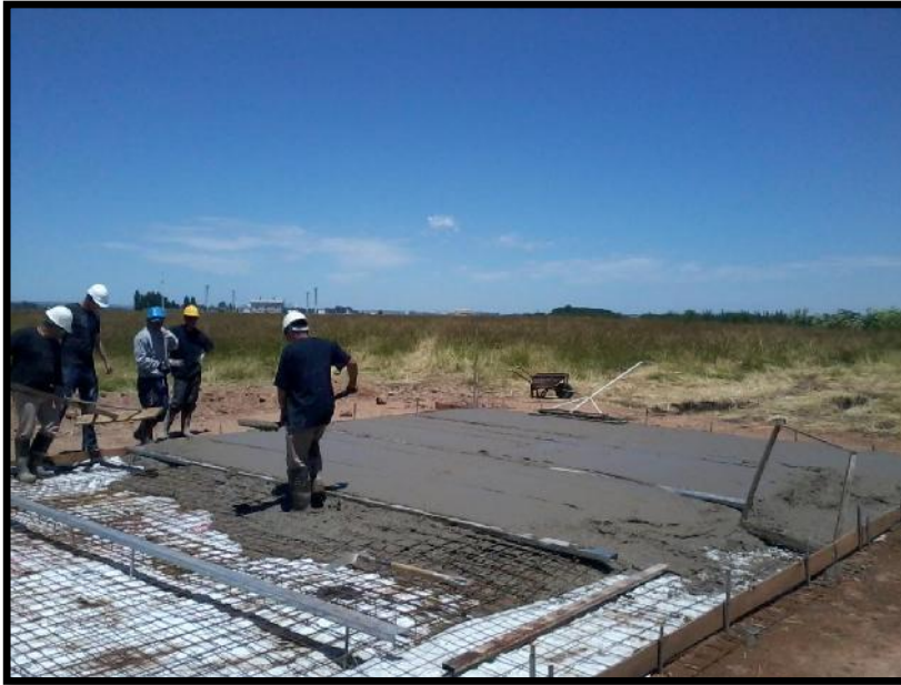
Ilustración 18.Preparación de platea
