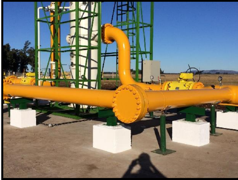
Ilustración 13. Soportería final de cañería.
