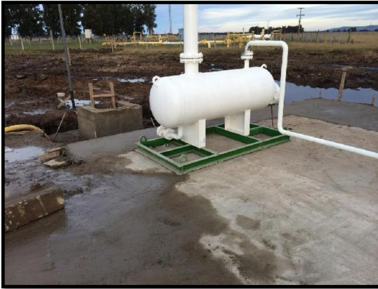
Ilustración 33. Tanque de choque en posición
