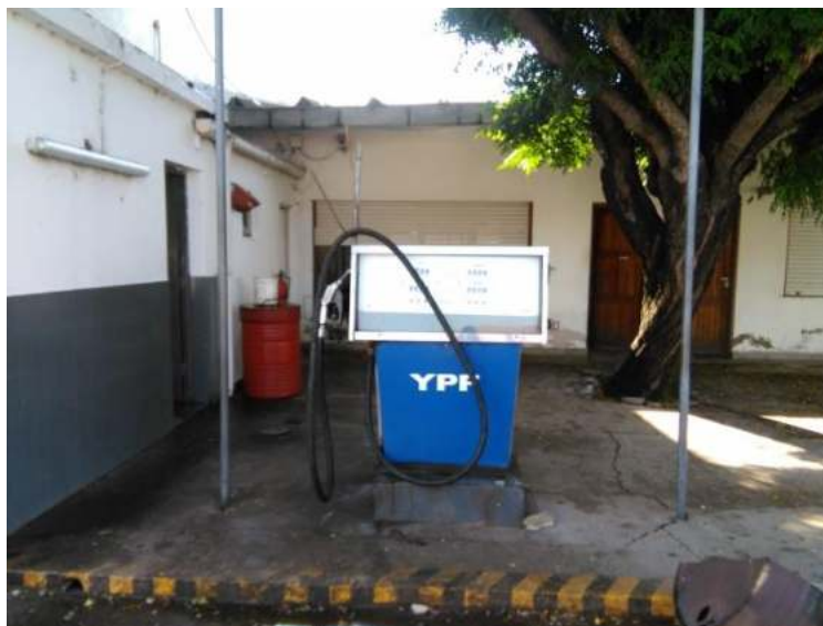
Ilustración 18. Imagen del Sector de carga de Gasoil.
