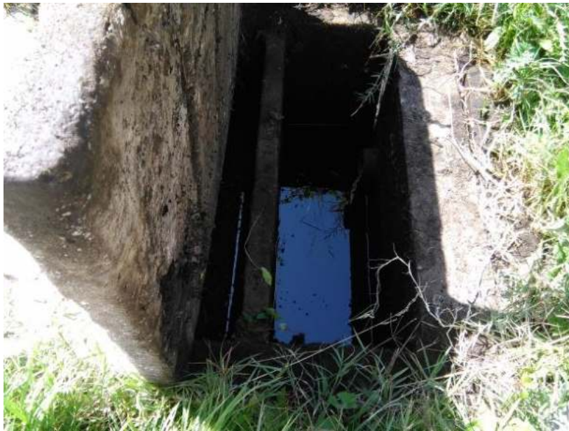
Ilustración 3. Decantador utilizado para los efluentes provenientes del Sector de Engrase y el Lavadero.
