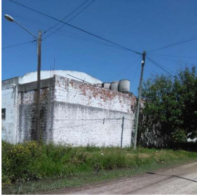
Ilustración 2. Tanques para el lavado de camiones.
