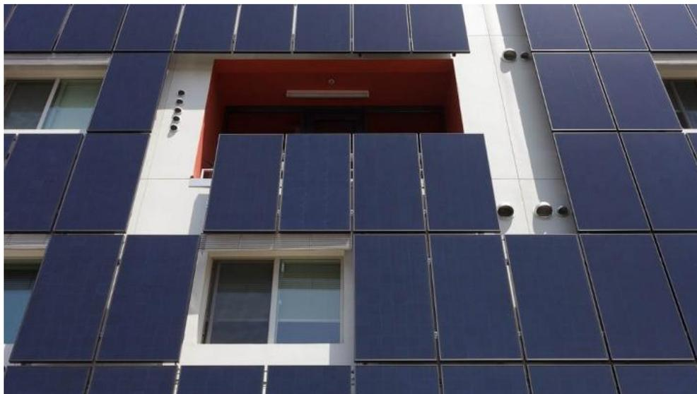
Figura 6.4 Colectores Solares en Muro de Edificio
