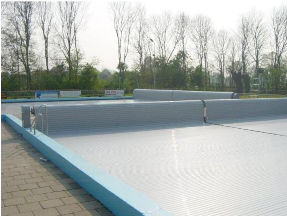
Figura 4.4: Mantas Térmicas para Conservación del Calor
