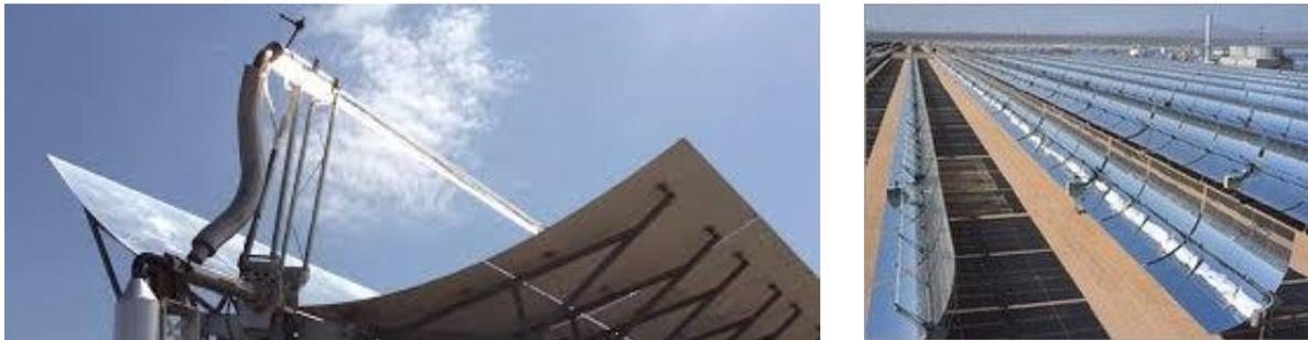
Figura 5.4: Colectores Concentradores de Calor de Alta Temperatura
