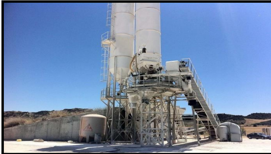
Figura 8: Planta amasadora de hormigón. Fuente: Centralde (2019).
