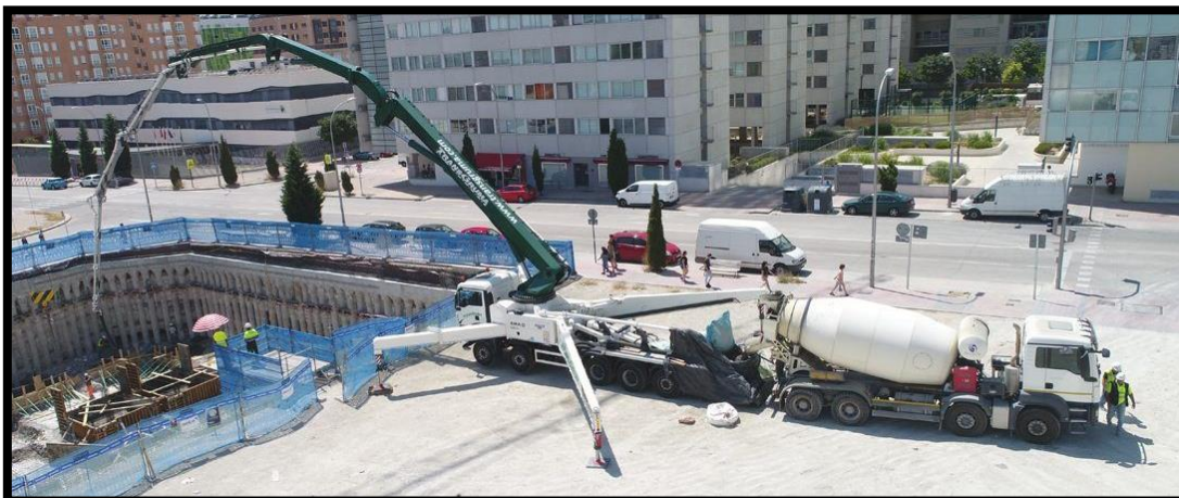
Figura 5: Bomba elevadora desplegada y camión hormigonera. Fuente: Transgruma (2019).
