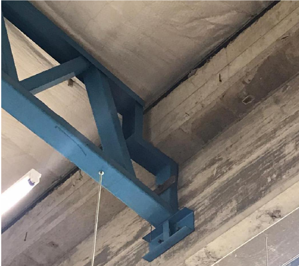
Figura 7.18 - Anclaje mecánico realizado en Biblioteca.
