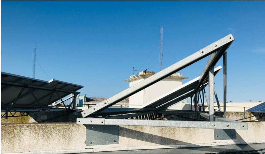
Figura 5.3 - Estructura soporte FI.
