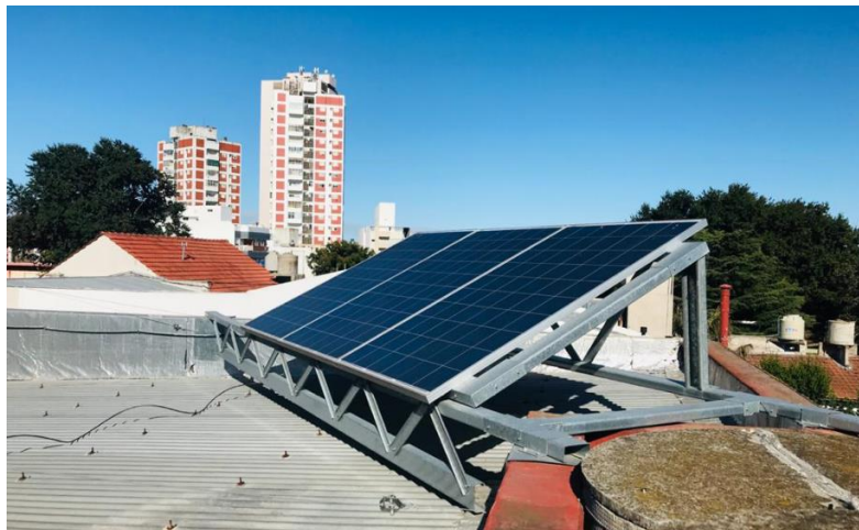
Figura 2.3 - Instalación FV Jardín UNMdP.
