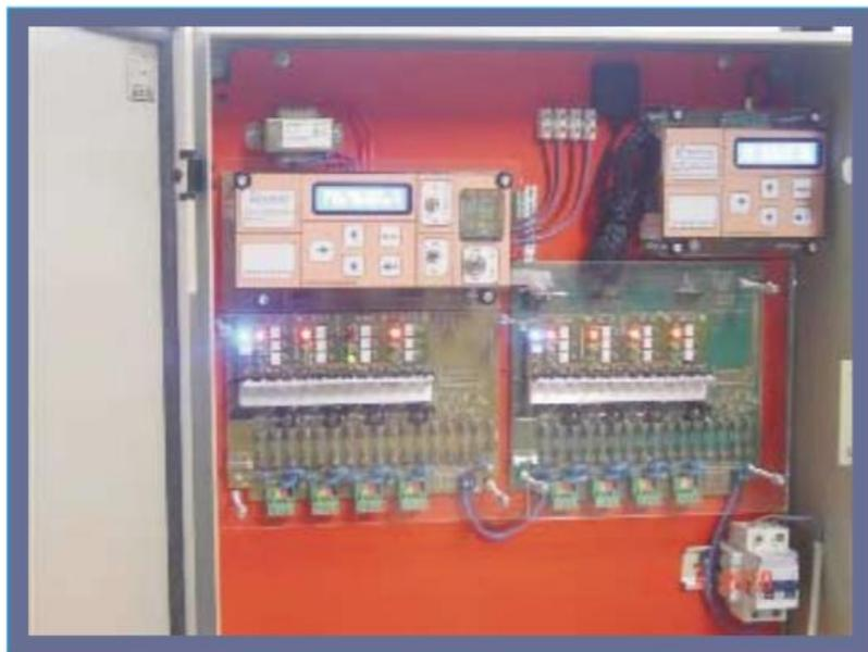
Figura 0.1 – Controlador semafórico programable con GPS de Micro electronica S.R.L
