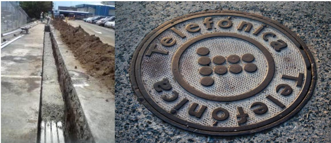
Figura 2-10-Canalización subterránea. Figura 2-11-Cámara de registro.
