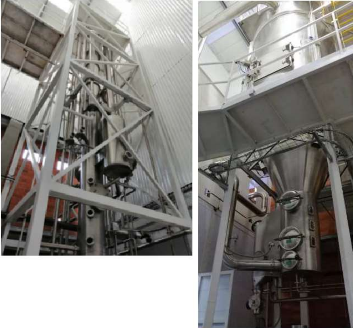
Gráfico 17 : Evaporador tipo falling film 1 FF con termocompresor (izquierda) y Secador en spray por atomización (derecha). Fuente: IAF Ingeniería.
