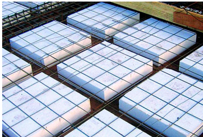
Figura 6: Fotografía de casetones utilizados en la losa de una construcción Fuente: Grupo Estisol, 2019
