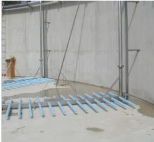
**Figura 48** - Sistema de aireación tubular.
