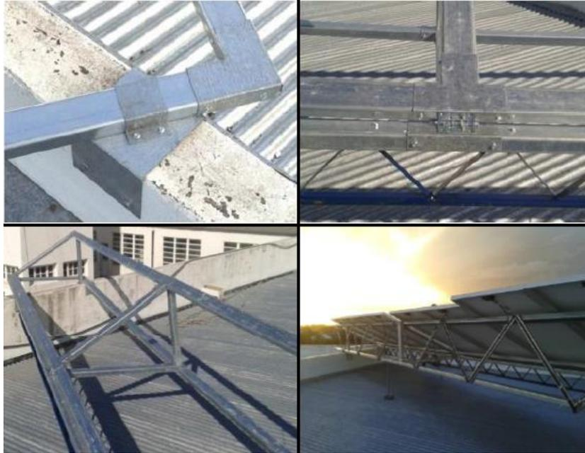
*Figura 4.3 - Componentes de la estructura de soporte de los paneles FV de la FI-UNMdP.*
