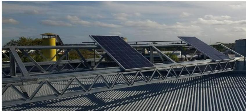
*Figura 4.2 - Estructura de soporte de los paneles FV de la FI-UNMdP.*
