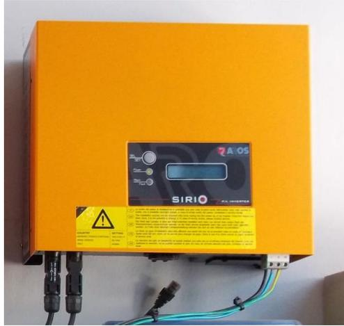
*Figura 4.5 - Inversor AROS SIRIO 1500 instalado en el LIC – FI – UNMDP*
