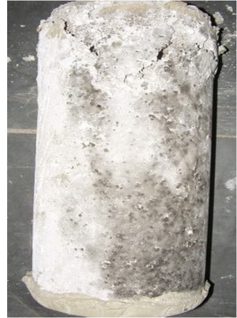
Fig. 4.13.4 – Hormigón con PS
