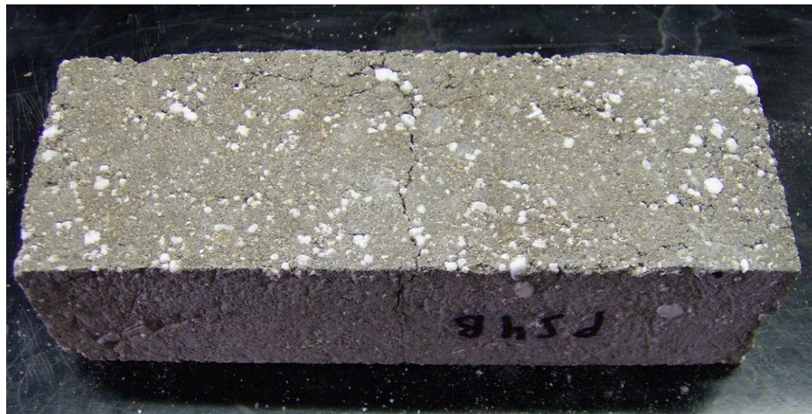
Fig. 4.8.4 – Fisura ramificada (PS2)
