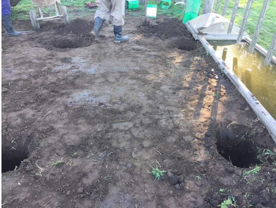
Figura 70: excavación para los soportes de la balanza.
