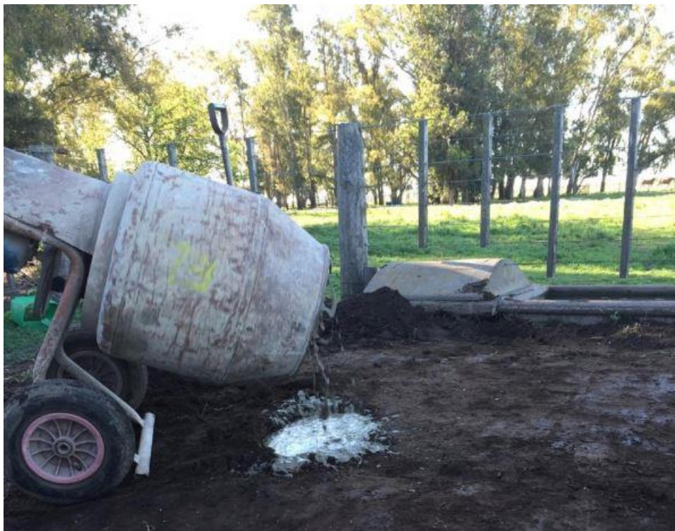
Figura 71: armado de los soportes de la balanza.
